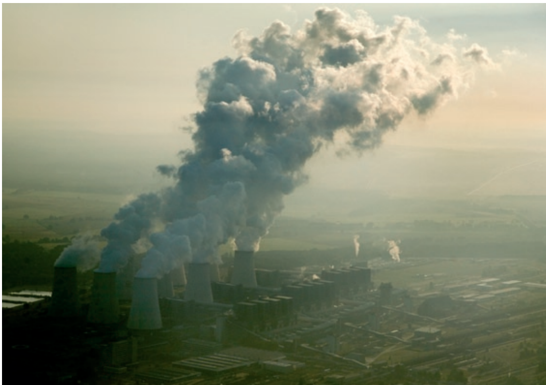
Braunkohlekraftwerk Jänschwalde, © Paul Langrock/Zenit/Greenpeace
